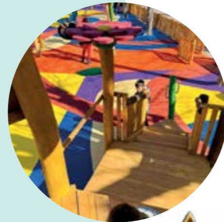
SUELO DE CAUCHO EPDM DE DIFERENTES COLORES QUE APORTA ALEGRÍA Y SEGURIDAD AL ESPACIO
